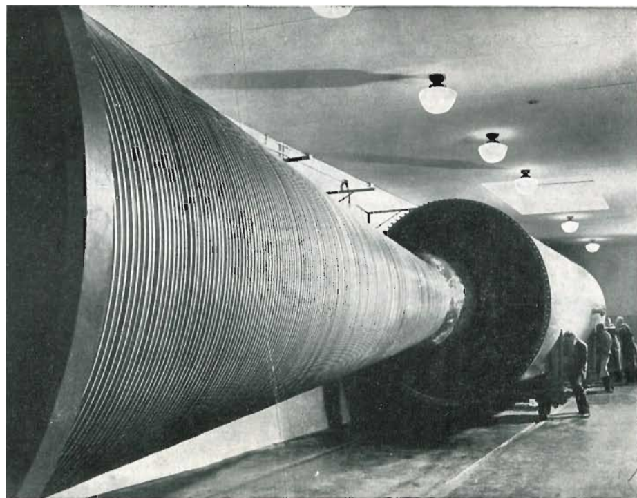
Un aspetto del nuovo disintegratore di atomi all'Università di Notre Dame. In funzionamento il carro cisterna da 15 tonnellate che appare sullo sfondo viene spinto in avanti a ricoprire l'intera struttura. Vi viene introdotta aria fino ad una pressione di 150 libbre per pollice quadrato: ciò eleva il voltaggio del generatore che può generare otto milioni di volt. Sarà usato per esperienze nella disintegrazione di nuclei con elettroni ad alta velocità nella produzione di metalli radioattivi. (Foto U.S.I.S.)
